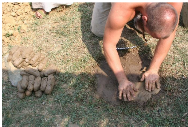
Slika 34. Zamazivanje baze ložišta Peći 3
