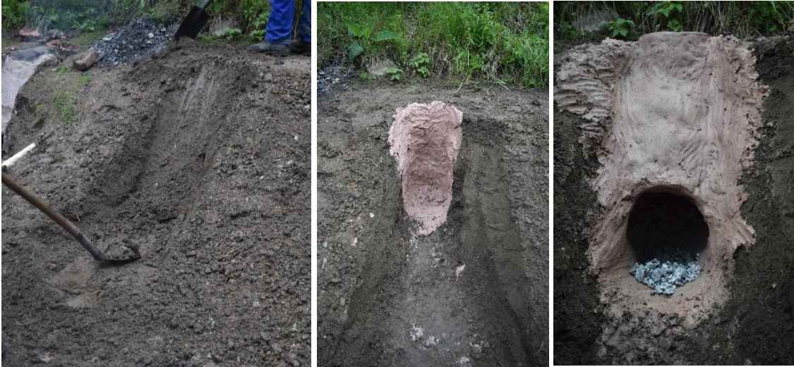
Slika 14. Peć 3.: faze izgradnje a) ukopavanje u padinu b) oblaganje ukopa glinom c) završena konstrukcija peći
