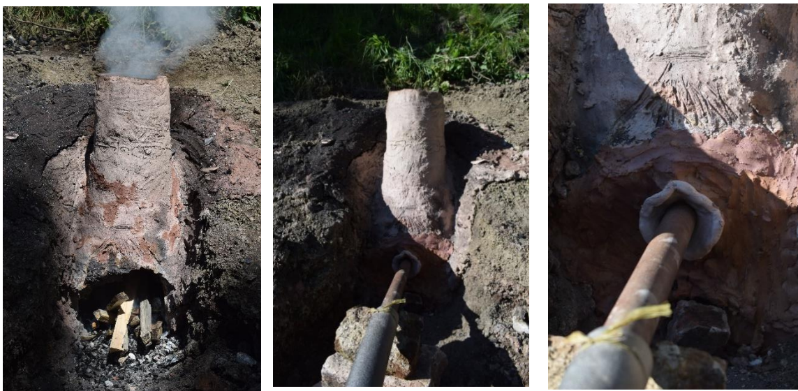
Slika 25. Sušenje obnovljenih dijelova peći
