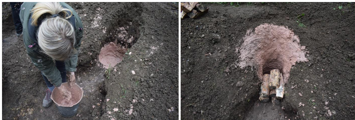
Slika 17. Oblaganje stijenki ukopa sa žitkom glinom
