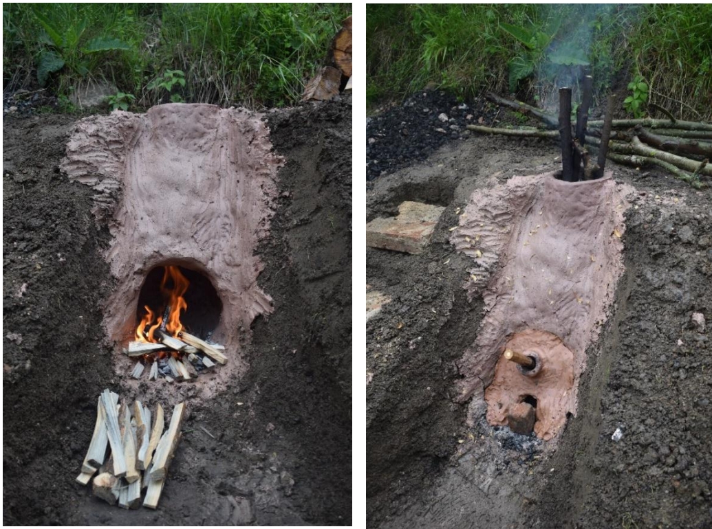
Slika 14. Peć 3.: faze izgradnje a) ukopavanje u padinu b) oblaganje ukopa glinom c) završena konstrukcija peći
