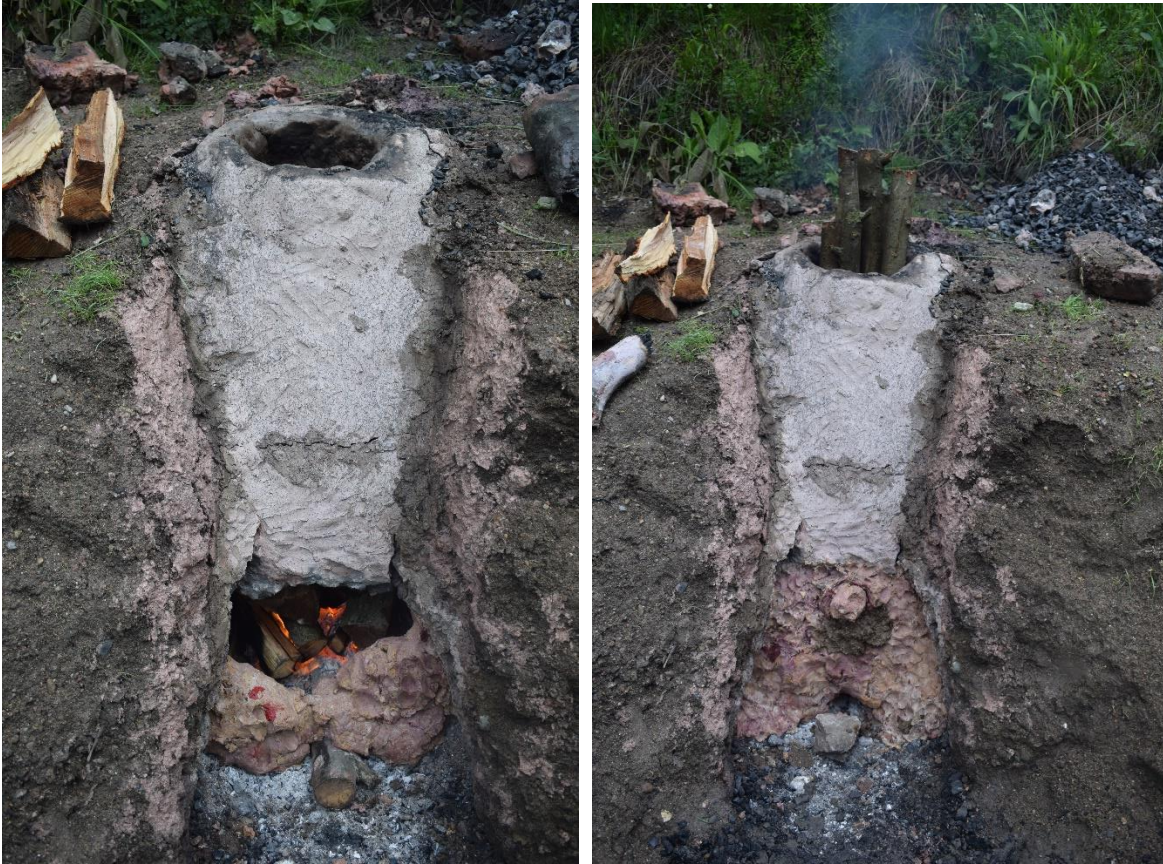
Slika 9. Peć 2.: Priprema za drugo taljenje - popravak (izgradnja vrata i zatvaranje pukotina) i sušenje
